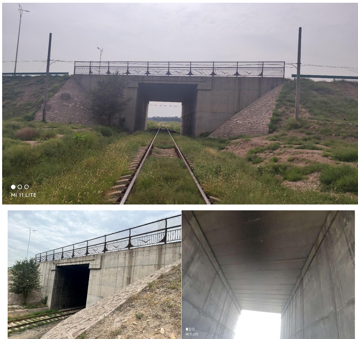
图 4-8 公铁立交桥现场照片
